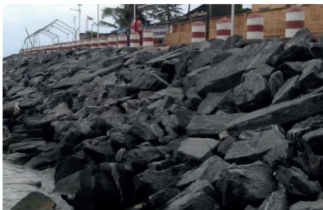
Récifs artificiels de protection de la côte contre l'érosion
